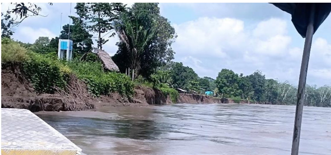
FIGURA N°02: SE OBSERVA LA EROSION DE LA MARGEN IZQUIERDA DEL RIO UCAYALI PARA PROTECCION CON GEOBOLSAS .
